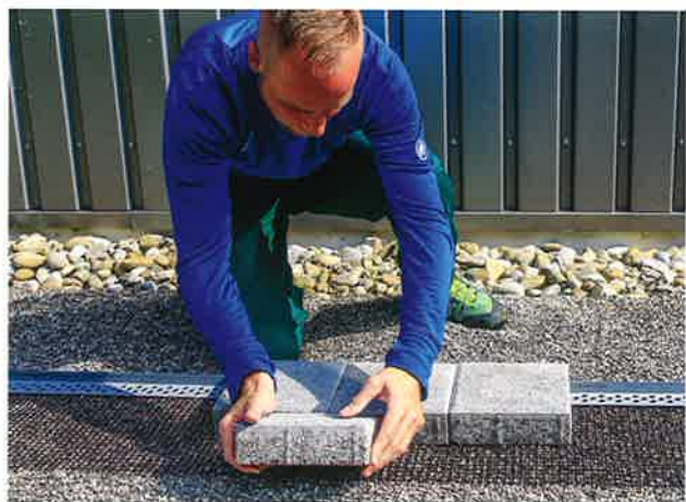
Avec le poids propre des pierres, le filet est durablement solidaire du gravier.
