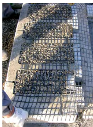
Géogrid (mise en place)
